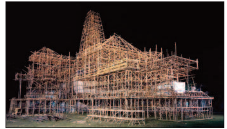
এদিকে এই রাম মন্দিরের আদলে তৈরি হওয়া মণ্ডপ সম্পর্কে মণ্ডপ শিল্পী তপনকুমার পাট্র জানান, অযোধ্যার রাম মন্দির বিরাট জায়গা নিয়ে তৈরি। কিন্তু এতটা জায়গা তিনি পাননি। গোটা মণ্ডপেই থাকছে ফাইবারের কাজ। পরিবেশ বান্ধব এই মণ্ডপ তৈরি করতে ব্যবহার করা হচ্ছে বাঁশ, ফোম, ভেবজ রং, পাট। মণ্ডপের চারপাশে নজরে আসবে রামের মূর্তি। রাম মন্দিরের চারপাশে দেখা যাবে নারায়ণ, রাম-সীতা ও হনুমানের মূর্তিও। আর মন্দিরের ভিতরে অধিষ্ঠিত থাকবেন দেবী দুর্গা। আর এই মণ্ডপের সঙ্গে সামঞ্জস্য রেখে সনাতনী রূপে মাতৃমূর্তি পূজিত হবেন পুজোর কয়েকটা দিন। এর পাশাপাশি এই মণ্ডপের চূড়ার সজ্জার দিকে দেওয়া হয়েছে বিশেষ নজর। প্রায় এক মাসের বেশি সময় ধরে এই মণ্ডপ তৈরির কাজ চলছে। মণ্ডপের সঙ্গে সামঞ্জস্য রেখে আলোকসজ্জাতেও থাকছে বিশেষ চমক। শব্দের সঙ্গে সামঞ্জস্য রেখে প্রতি মুহূর্তে রং
